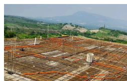
ARMADO DE LOSA
